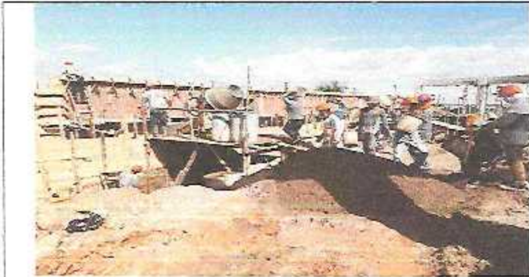
FOTO 12: VACEO DE MURO DEL SKATE PARK 02
