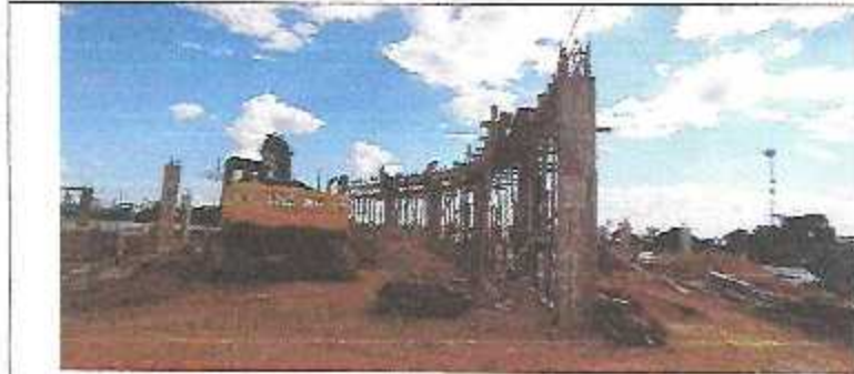
FOTO 14: ENCOFRADO Y COLOCACION DE ACERO EN VIGAS DE PERGOLAS DE BANCAS
