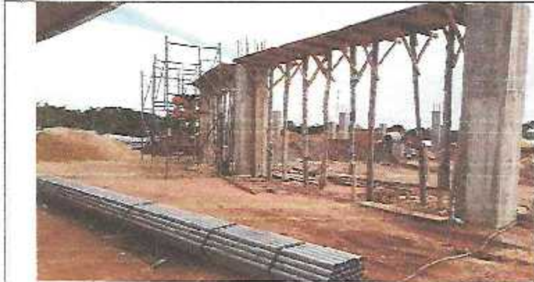
FOTO 13: ENCOFRADO DE VIGAS DE LAS PERGOLAS DE BANCAS
