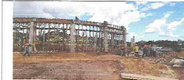
FOTO 15: ENCOFRADO Y COLOCACION DE ACERO EN VIGAS DE PERGOLAS DE BANCAS
