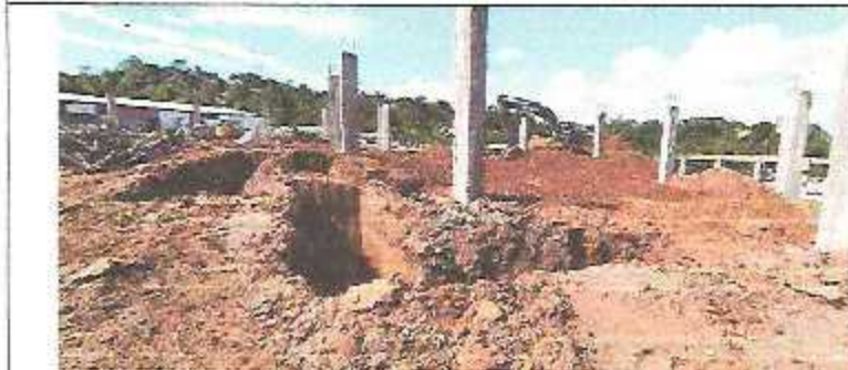
FOTO 21: EXCAVACION DE ZANJA PARA MURETES EXTERIORES
