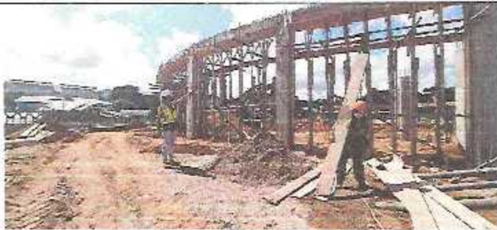
FOTO 16: ENCOFRADO DE VIGAS DE LAS PERGOLAS DE BANCAS
