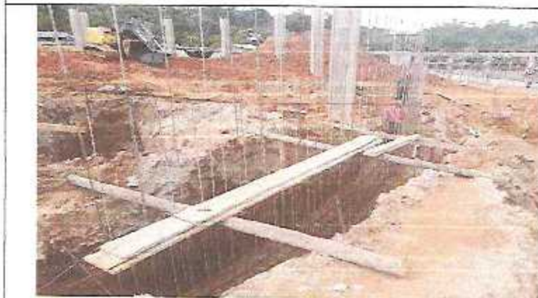
FOTO 23: COLOCACION DE ACERO EN ZAPATAS Y MURO DE MURETES EXTERIORES
